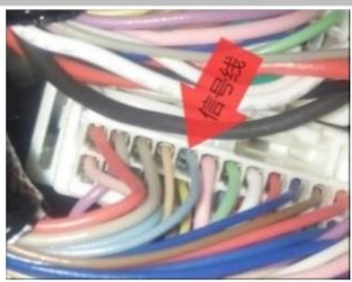
3.17 接控制信号线 ：蓝色线为原车的控制信号线，需要和我们的控制信号线相接
