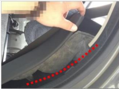
3.30 布线: 穿过后门迎宾踏板胶条内侧延伸至主驾驶室预留合适线束连接, 负极线束延伸到尾箱左侧
