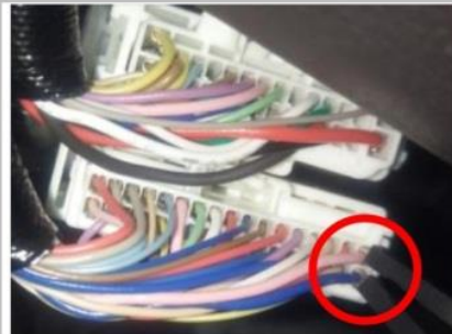
3.13 接解码器 CAN 信号 ：拆下左后边的盖板后可以看到我们要接信号线的位置（倒车雷达模块），图所示，然后剥开波纹管，找到线束
